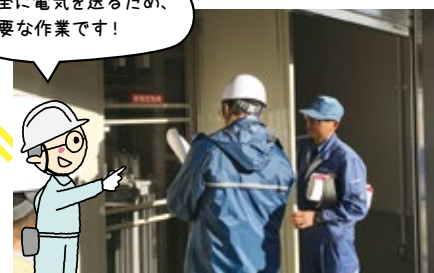
8 確認・点検 設置した新しいキュービクルが、問題なく動作することを確認します
