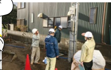
7 計器類を設置 新しいキュービクルのための電柱に計器類を設置します
