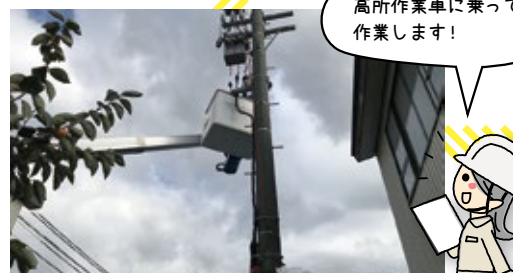
6 電線を接続 新しいキュービクルと電力会社の電線を接続
