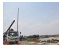
東日本大震災の復旧
