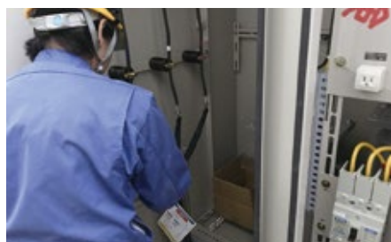
5 ケーブルの接続 新しいキュービクルにケーブルを接続します
