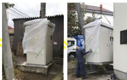
4 新しいキュービクルの搬入と設置 クレーンで搬入し、土台の上に設置して固定
