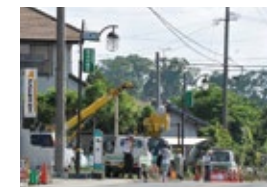
熊本地震の復旧
