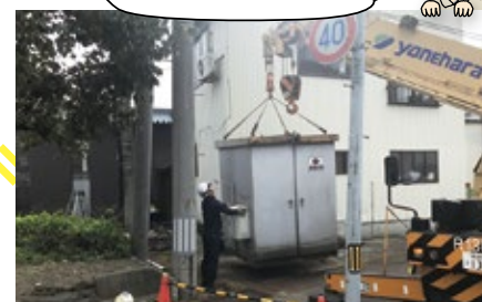
2 キュービクルの取替え 交換のため、古くなったキュービクルを撤去
